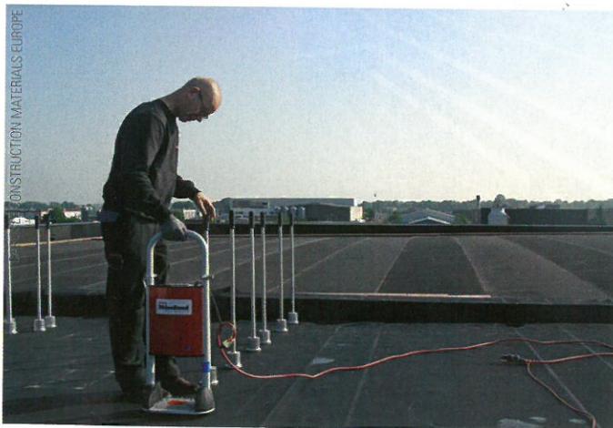
Die EPDM-Plane wird mittels Induktion mit den Haltetellern verschweißt.
