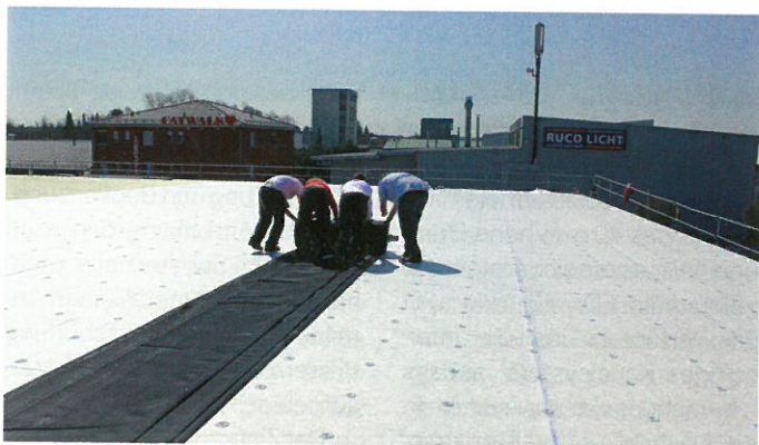
Die Plane wird über der befestigten Dämmung ausgelegt.
