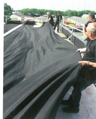
Ausbreiten der Plane durch Unterwedeln von Luft.
